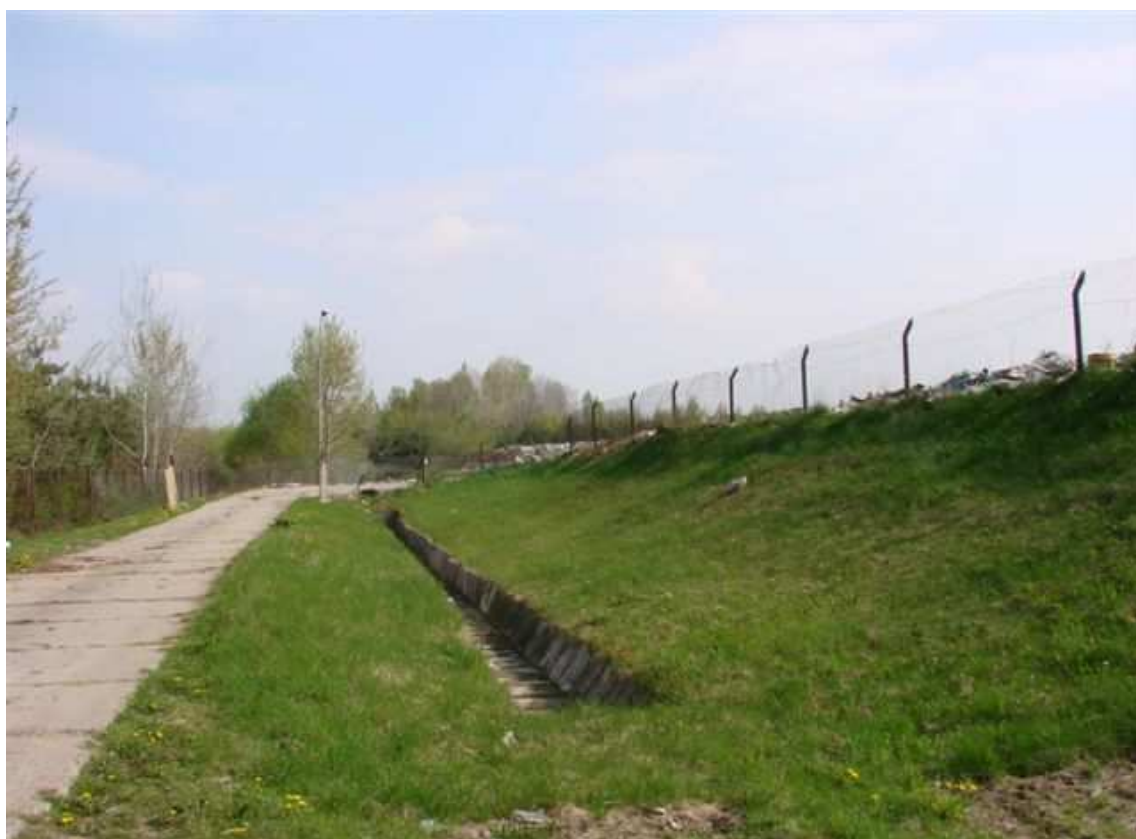
Fot. 4. Droga dojazdowa do I kwatery składowiska
